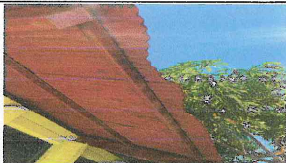
Foto 6: TECHO DE CORREDORES
