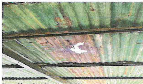
Foto 2: TECHO DE GALERA
