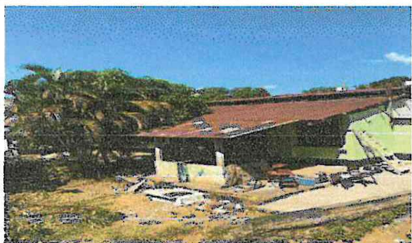
Foto1: TECHO DE SALONES DE PREPRIMARIA VISTA DE ARRIBA
