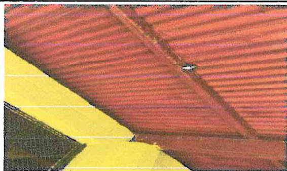
Foto 3: CORREDOR DE AULAS
